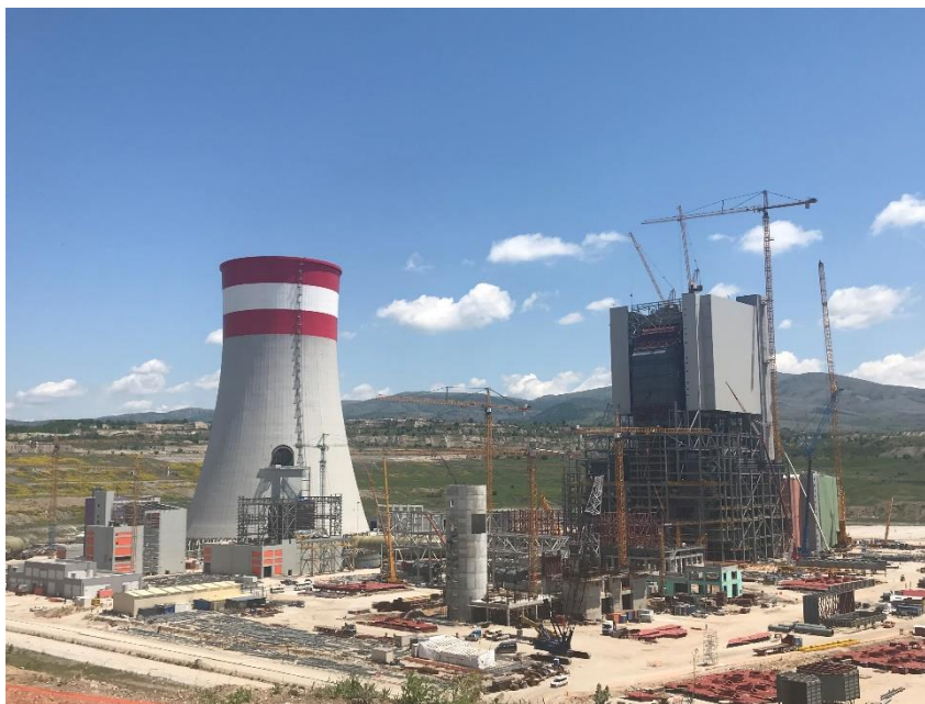
Εικόνα 24: Άποψη του έργου κατασκευής του ΑΗΣ Πτολεμαΐδας V
