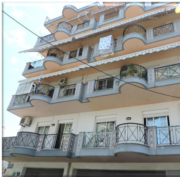
Εικόνα 4: Πολυκατοικία στο νομό Ροδόπης
