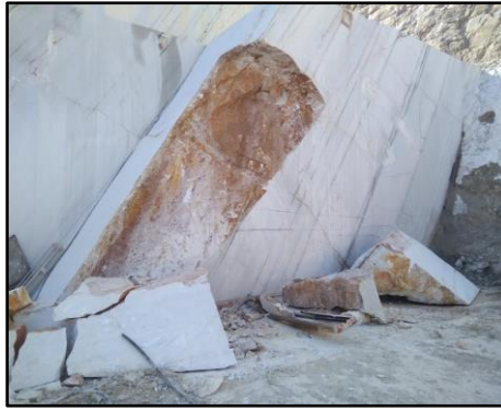
Εικόνα 9: Μέτωπο μαρμάρου όπου σημειώθηκε αστοχία και κατακρίμνηση όγκου πετρώματος με συνέπεια τον ακρωτηριασμό άκρου του εργαζόμενου.
