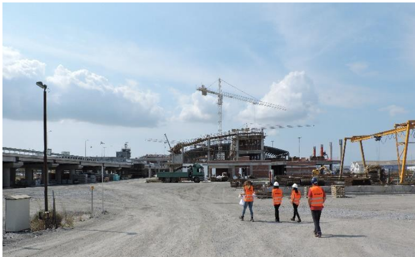
Εικόνα 23: Άποψη του έργου εκσυγχρονισμού και επέκτασης του αεροδρομίου «Μακεδονία» στη Θεσσαλονίκη
