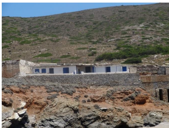
Εικόνα 22: Αυθαίρετη κατασκευή εντός της Ζώνης 1 του διατάγματος προστασίας της νήσου Μακρονήσου
