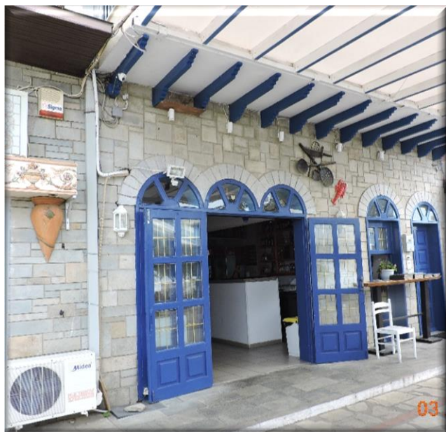
Εικόνα 3: Κατάστημα στο Ν.Χαλκιδικής
