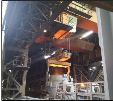
Εικόνα 7: Γερανός στο μεταλλουργικό εργοστάσιο στο φορείο του οποίου έλαβε χώρα το δυστύχημα.
