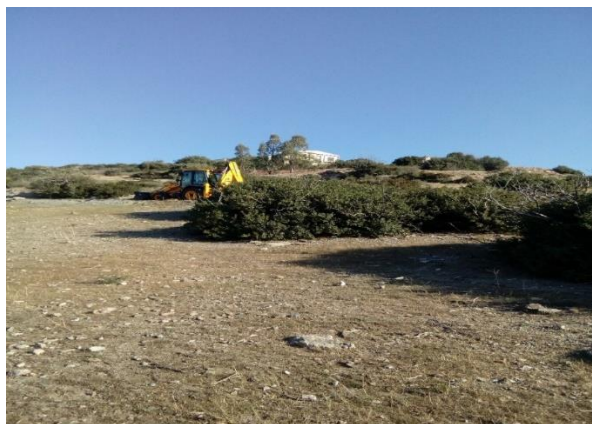
Εικόνα 21: Αποκατάσταση σε προτέρα κατάσταση κατά την εκτέλεση απόφασης κατεδάφισης
