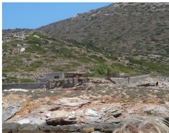
Εικόνα 23: Αυθαίρετη κατασκευή εντός της Ζώνης 1 του διατάγματος προστασίας της νήσου Μακρονήσου
