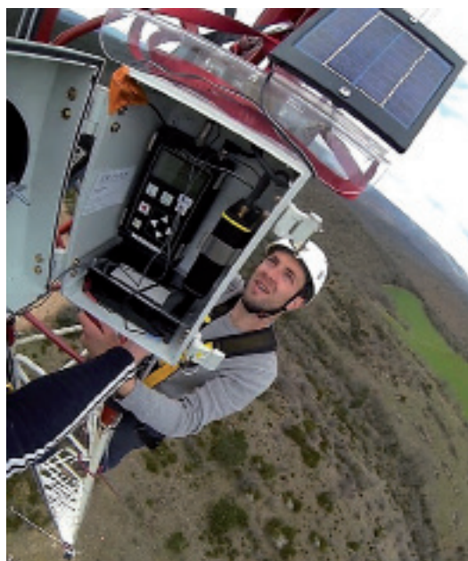
Αυτοματοποιημένο σύστημα δέκτη υπερήχων εγκατεστημένο σε έναν μετεωρολογικό ιστό στη Γαλλία. © EXEN
