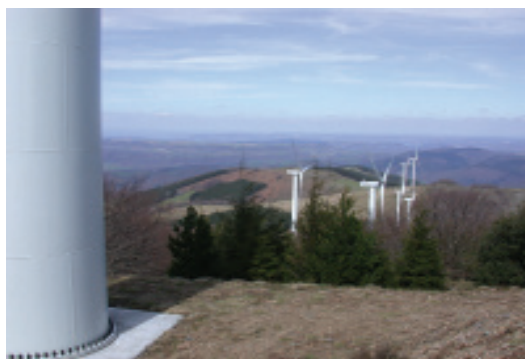
Αιολικό πάρκο κατασκευασμένο το 2002 (Aveyron, Γαλλία) σε κορυφογραμμή στο όριο ενός δάσους οξιάς. Εκείνη την περίοδο υπήρχε περιορισμένη έρευνα σχετικά με τις επιπτώσεις των ανεμογεννητριών στα χειρόπτερα και δεν πραγματοποιούνταν ΕΠΕ για νυχτερίδες. © M.-J. Dubourg-Savage
