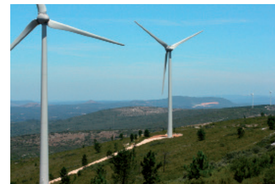
Στην Πορτογαλία, αυτό το αιολικό πάρκο έχει μια από τις 7 ανεμογεννήτριες τοποθετημένη 158 μέτρα από ένα σημαντικό χειμερινό καταφύγιο (περίπου 4000 Miniopterus schreibersii και 150 Rhinolophus ferrumequinum ). Η ταχύτητα ανέμου ενεργοποίησης (cut-in wind speed) αυτής της ανεμογεννήτριας έχει αυξηθεί στα 5 m/s τον Οκτώβριο, Νοέμβριο, Δεκέμβριο, Μάρτιο και Απρίλιο. © J. Rydell
