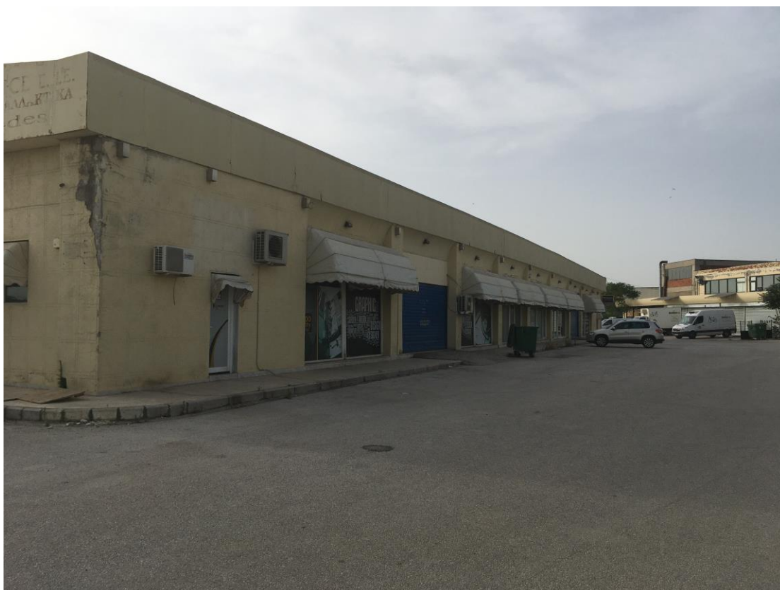
Εικόνα 5.4: Άποψη του Κτιρίου Γ
