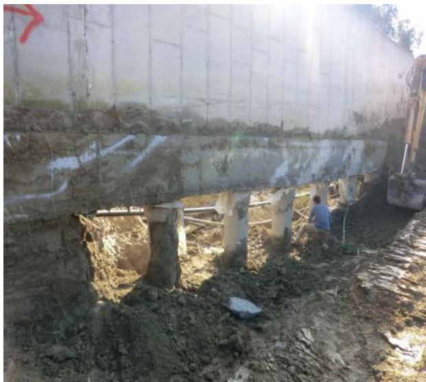
Εικόνα 4-10: Υποσκαφή πασσαλότοιχου ΒΙΟΚΑ
