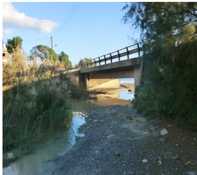
Εικόνα 4-7: Τεχνικό ρεμάτων Κεντριανού Κοτοβιανού πριν την εκβολή
