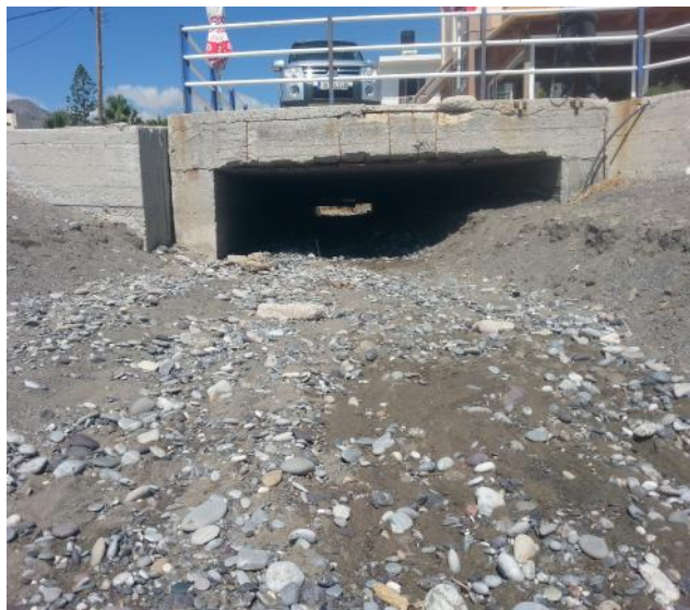
Εικόνα 4-6: Τεχνικό εκβολής ρέματος Διαβατών
