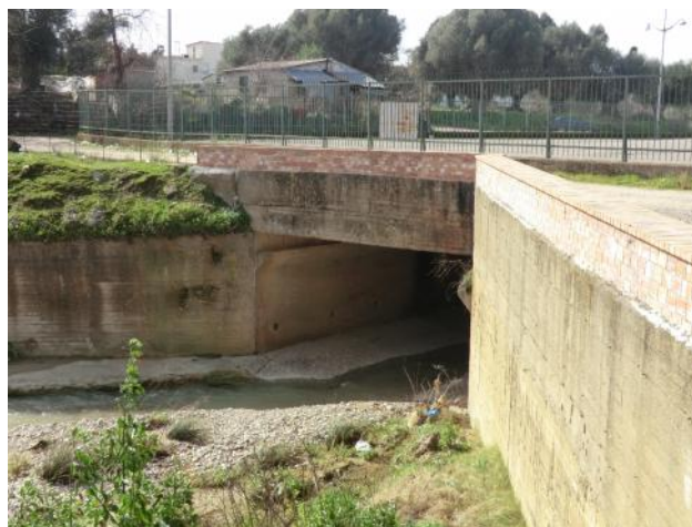
Εικόνα 4-13: Τεχνικό εισόδου κάλυψης Ρ. Σοχιά στην Αμαλιάδα
