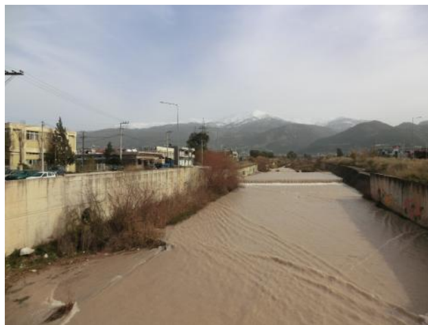
Εικόνα 4-11: Διευθετημένη κοίτη και αναβαθμός Γλαύκου.
