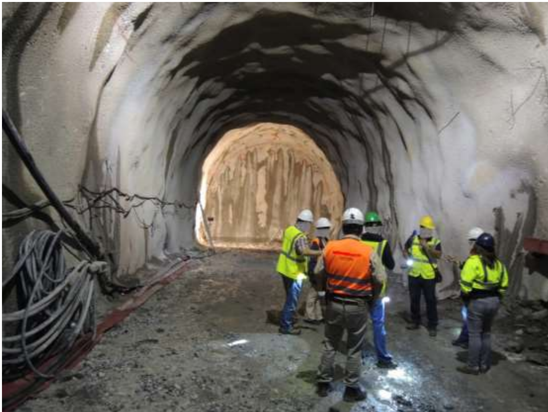
Εικ. 5.1.1: Κύρια σήραγγα πρόσβασης σε μεταλλείο εξόρυξης στο Ν. Χαλκιδικής
