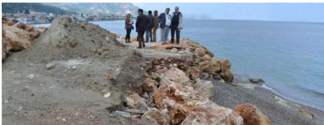
Εικ. 3.3.3: Διάβρωση μετώπου ακτής και επεμβάσεις στην ακτογραμμή στο Δερβένι Κορινθίας
