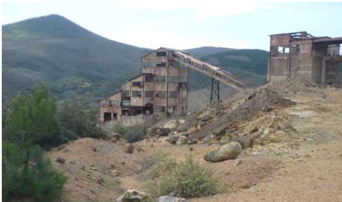
Εικ. 3.3.8: Ανενεργό εργοστάσιο εμπλουτισμού στην περιοχή Κίρκη Αλεξανδρούπολης
