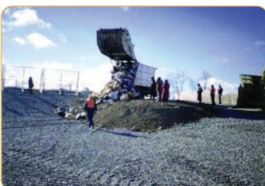
1. Η ράμπα εισόδου των οχημάτων στην κυψέλη κατασκευάζεται από πάνω προς τα κάτω, έτσι ώστε τα μηχανήματα που τη διαμορφώνουν να εδράζονται πάντα πάνω στο εδαφικό υλικό κατασκευής της ράμπας και όχι στον πυθμένα του XYTA.
