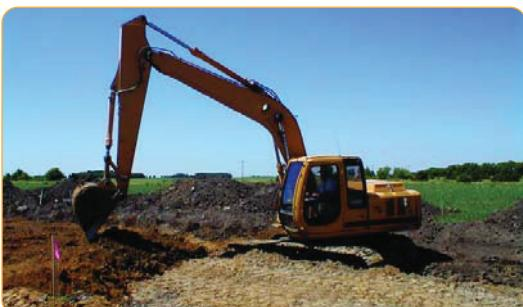
Η εκσκαφή του χώματος που θα χρησιμοποιείται ως υλικό επικάλυψης θα πρέπει να γίνεται μόνο στους καθορισμένους δανειοθαλάμους. Το πότε θα τερματίζεται η εκσκαφή από ένα σημείο και θα συνεχίζεται σε ένα διπλανό σημείο, θα ορίζεται από τον υπεύθυνο μηχανικό του έργου.
