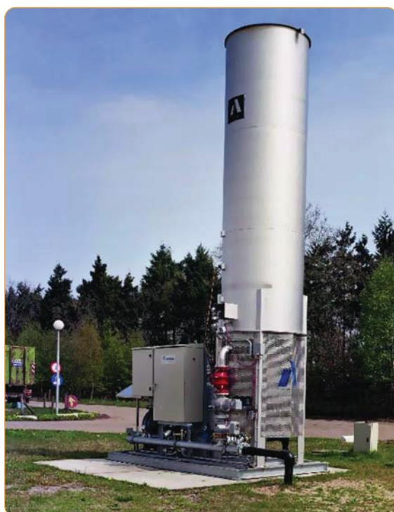
Τυπική εγκατάσταση άντλησης και καύσης βιοαερίου κλειστού τύπου
